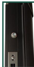
une butée et un ergot anti-soulèvement par panneau (portillon)
